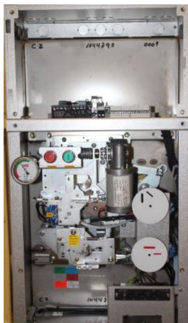
1VDD201025 Kompletní motorické ovládání na pohonném mechanismu 3PKE pro modul C
